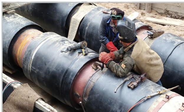
3.5.4.13. Теплогидроизолированные сильфонные компенсационные устройства типа ППУ/ПЭ.И и ТГИ.И с усиленной гидроизоляцией применяются при бесканальной прокладке трубопроводов, а также в случаях их прокладки в непроходных каналах. Допускается эксплуатация SKU во влажных грунтах с высоким уровнем грунтовых вод и в непроходных каналах, не оборудованных дренажной системой и подверженных затоплению грунтовыми, сточными или ливневыми водами.
